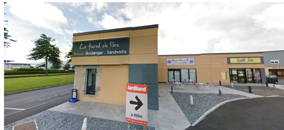
Cellules commerciales en périphérie du centre-ville de Fougères, Lécousse
