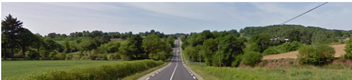
Vue de la D177 en allant vers Louvigné-du-Désert
