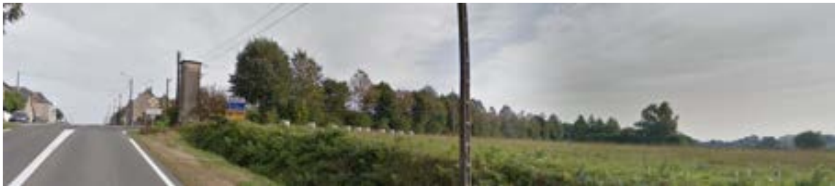
Entrée de la commune de Louvigné-du-Désert par la D177 Sud
